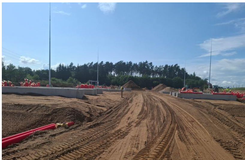
Pav. 2 Elektros energijos kaupimo įrenginių (EEKI) sekliųjų pamatų įrengimo ir statybvietės paruošimo darbai. Fig. 2 Installation of shallow foundations and site preparation works for Electrical Energy Storage (EES) facilities.
