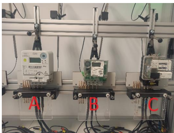
1 pav. Elektros skaitiklių pajungimas metrologiniame stende: A – XS211, B – G1A, C – CO-U449M2
