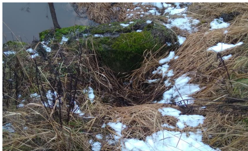
2 pav. Ant pralaidos atsiradęs įsiurbimas-nuosėdis
