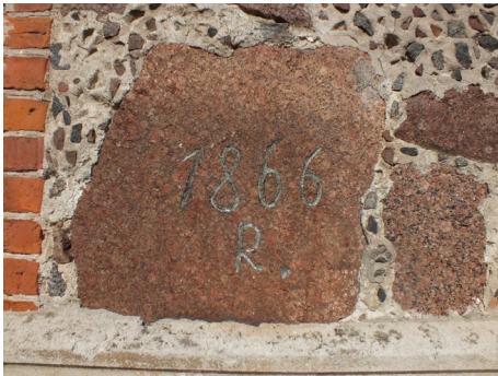
2 pav. Šunskų Šv. Marijos Magdalietės bažnyčia. Bažnyčios pastatymo datos įrašas, iškaltas pietinio fasado akmenyje
