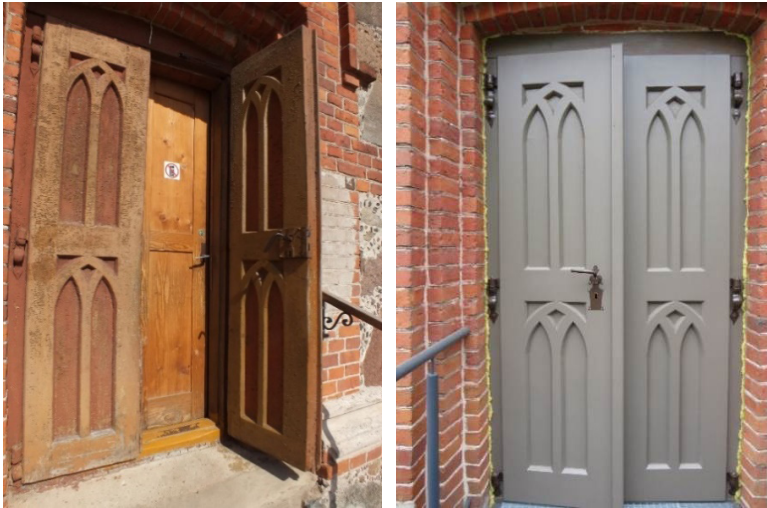
8 pav. Šunskų Šv. Marijos Magdaliėtės bažnyčia. Šoninės įėjimo durys prieš ir po restauracijos
